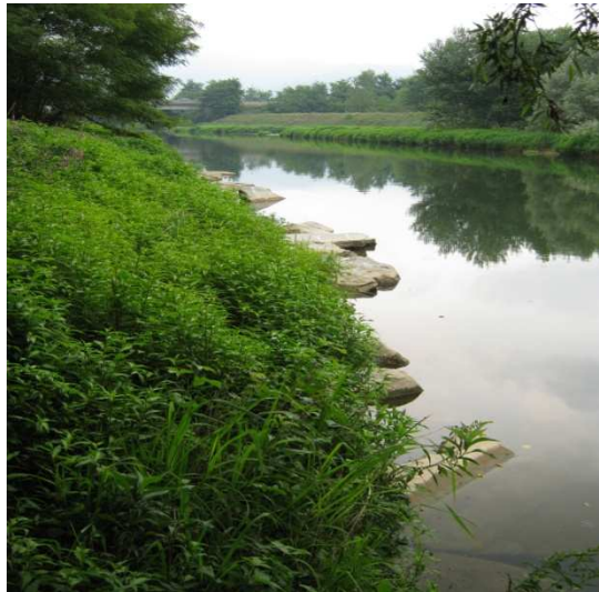
Figura 19 – Tratto a valle della S.P. 220 vista verso valle: in sponda sinistra sono visibili i massi scalzati della scogliera in corrispondenza dello stabilimento ESSO.
